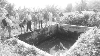
गाउँमा निर्माण गरिएको पानी ट्याङ्की ।
